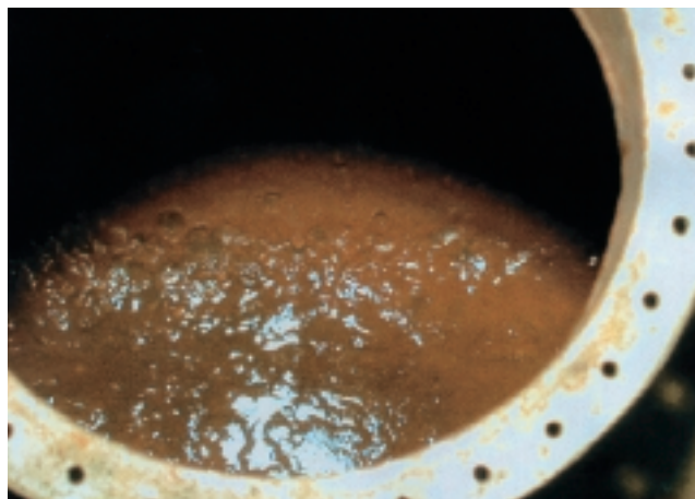
Kontaminierter VE-Wasser-Pufferbehälter.
