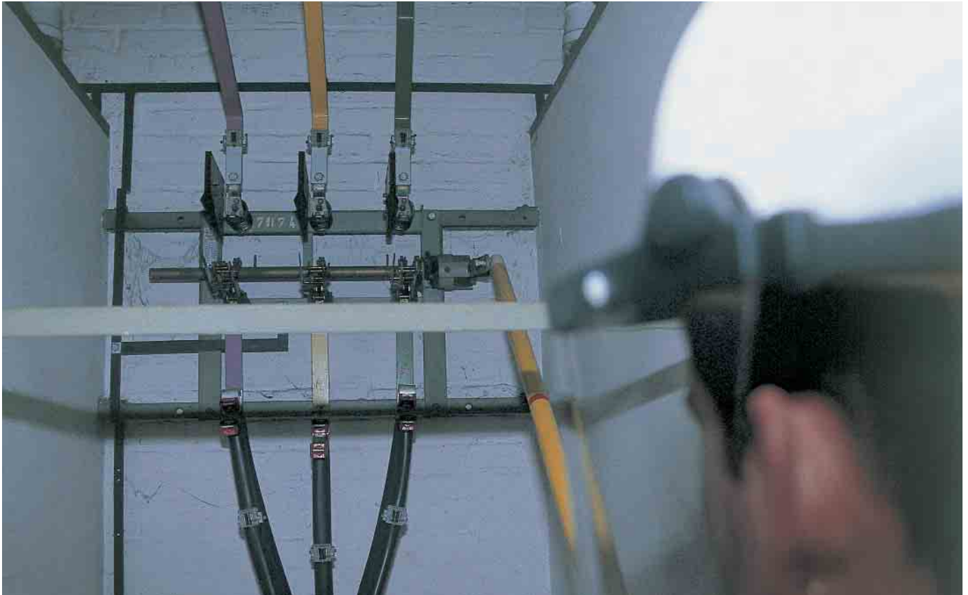
Öffnen eines Lasttrennschalters mit Schaltstange
