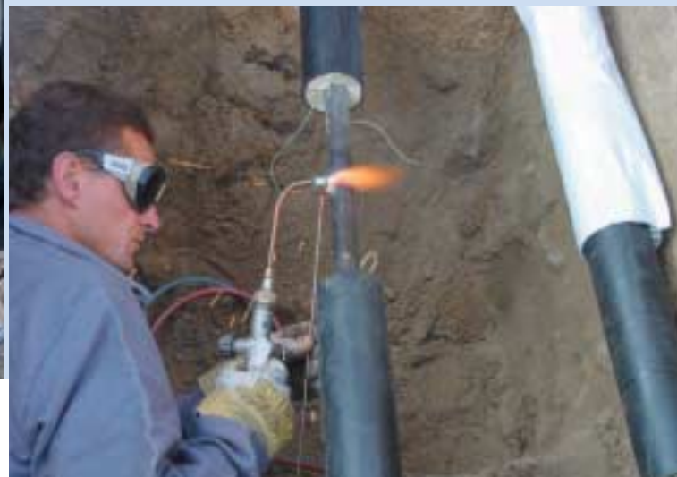
Die Verbindungsleitungen zu einem Hausanschluss werden im drucklosen Zustand stumpf miteinander verschweißt.
