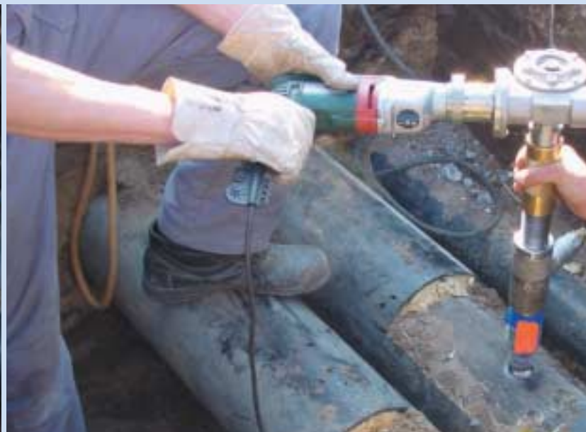
Beim Anbohrvorgang durch einen Anschweißstutzen mit integrierter Absperrvorrichtung tritt kein Heizmedium aus.
