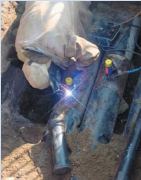
Auf die freigelegten Fernwärmerohrleitungen werden Anschweißstutzen mit integrierten Absperrorganen aufgeschweißt.
